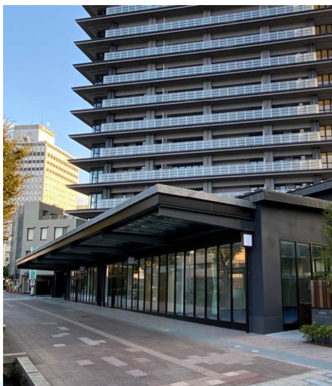
▲ 歩行者に配慮したアーケード
