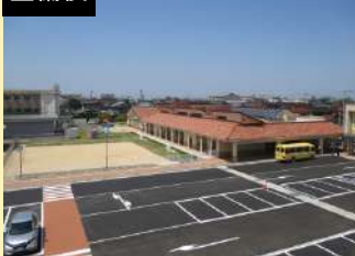
▲ 寺井保育園整備
