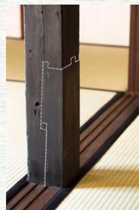
柱の根継ぎによる健全化
