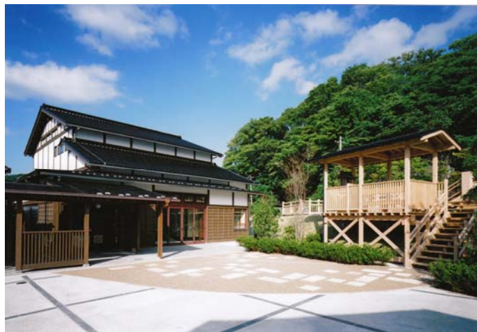
景観基準に合わせて整備された交流施設
