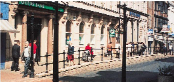
車椅子の方でも利用しやすいように、銀行の出入口の高さに合わせて歩道全体をスロープ式にしている。
