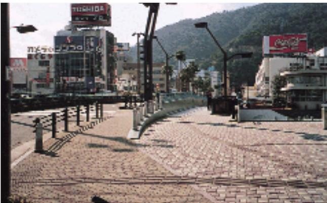
橋梁の縦断勾配が急だったため、平坦な歩道橋を増設し、車椅子や自転車の方も通行しやすくしている。
