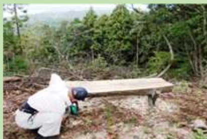
木製ベンチを設置
