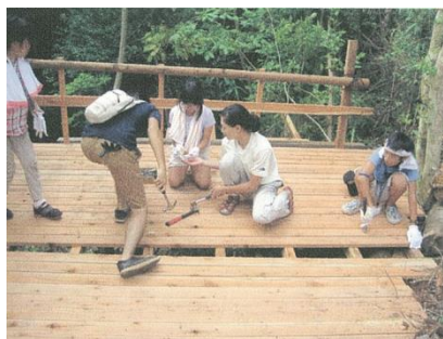
ウッドデッキづくり：七尾市
