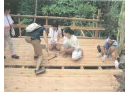
能登島自然の里ながさき （ウッドデッキづくり・七尾市）
