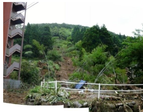
土砂災害が発生した竹林(金沢市板ヶ谷地内)
