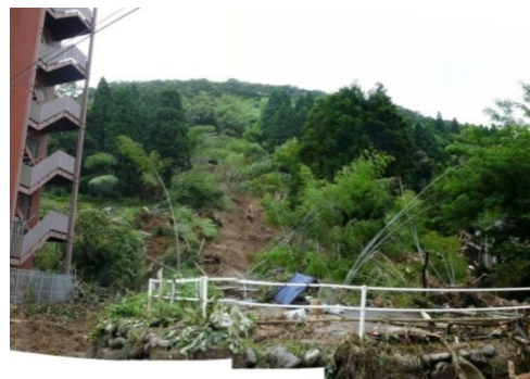
豪雨により崩壊した、竹が侵入した人工林(金沢市)
