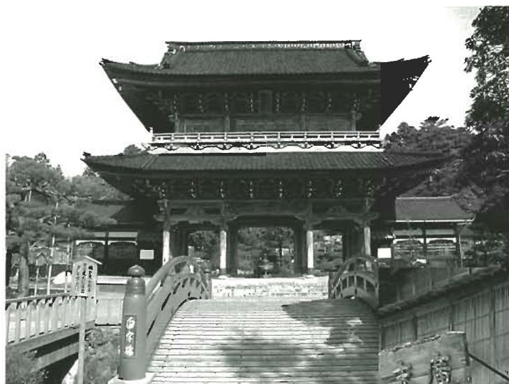
座禅堂などに大きな被害が出ているが、拝観を再開している総持寺祖院(輪島市門前町)
