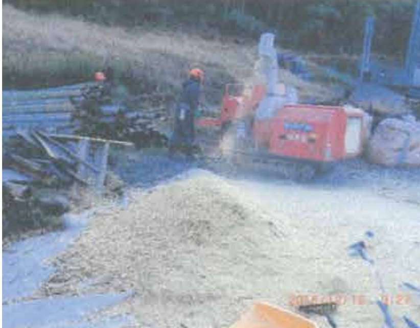
破砕機稼働中
