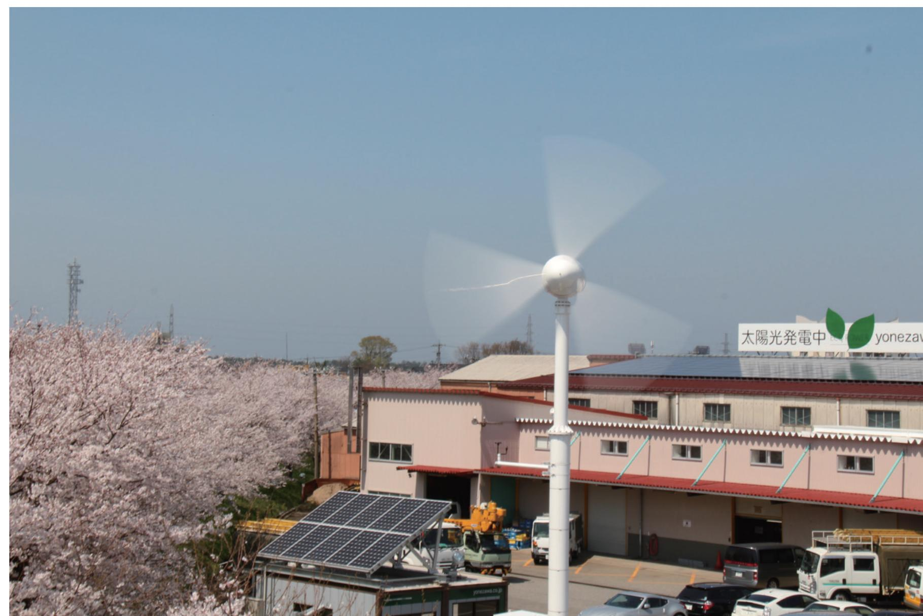
本社駐車場で設置工事を行っていたハイブリッド発電設備が設置され、現在、その設備の実証実験を行っています。この設備は、太陽光・風力の再生可能エネルギーをマルチ入力し、マイクログリッドコントローラーで蓄電池に充電し、電力の出力制御を行い、電気自動車の急速充電や災害時の非常用電源などに利用されます。また、日中のピークカットや節電・省エネ対策に有効です。
