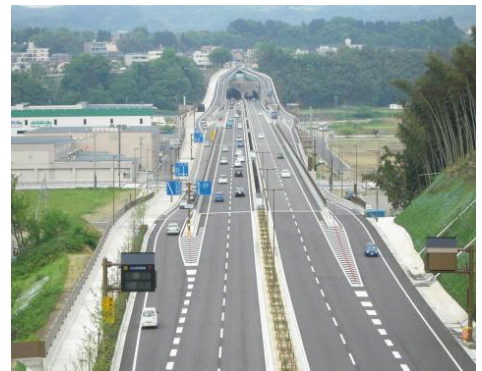
山側環状道路(大桑高架橋)
