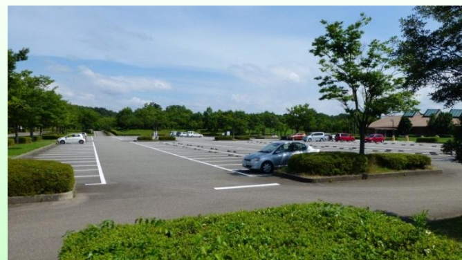
③ 駐車場状況
