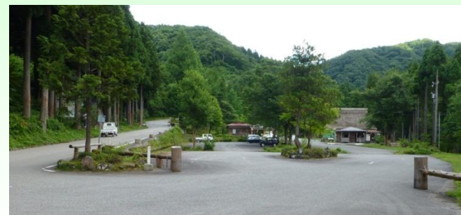
③ 駐車場状況
