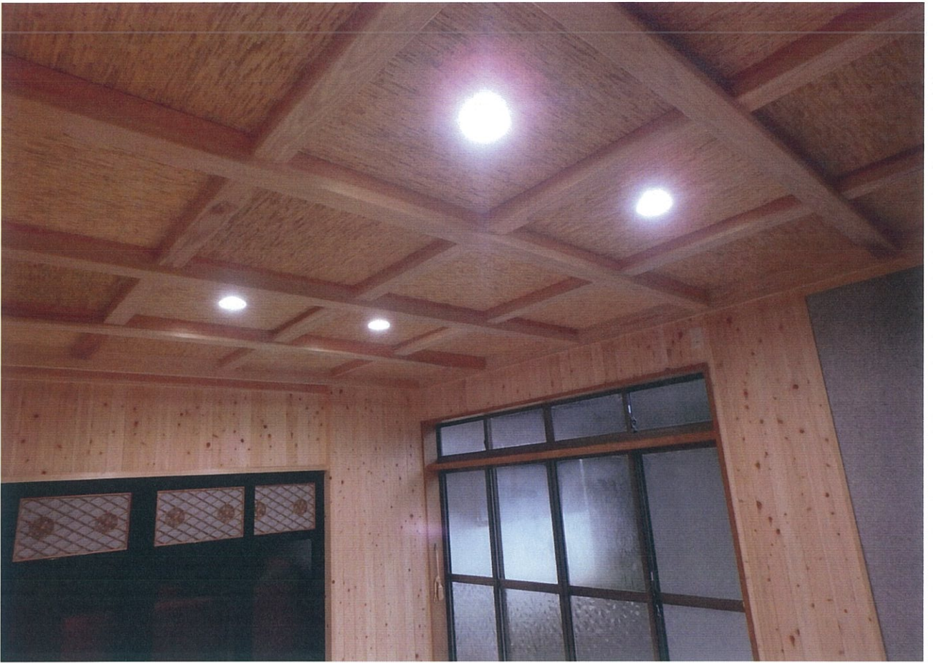
天井材・内壁(羽目板)
