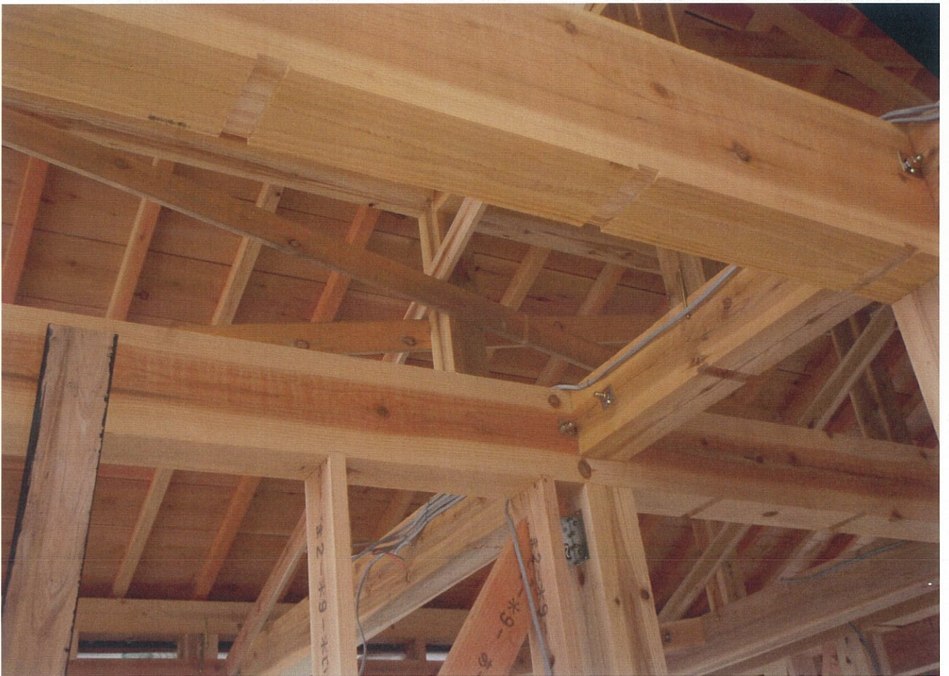
柱・梁・桁・母屋・小屋束
