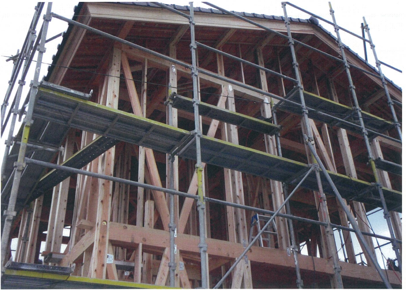
柱・梁・桁・破風板・鼻隠し
