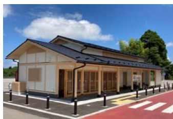
(2)県産材利用施設部門 七尾城登山口駐車場休憩案内所 (七尾市)
