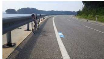
サイクリング環境の整備
