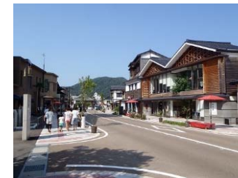
無電柱化を核とした街並み景観の形成(山中温泉ゆげ街道)
