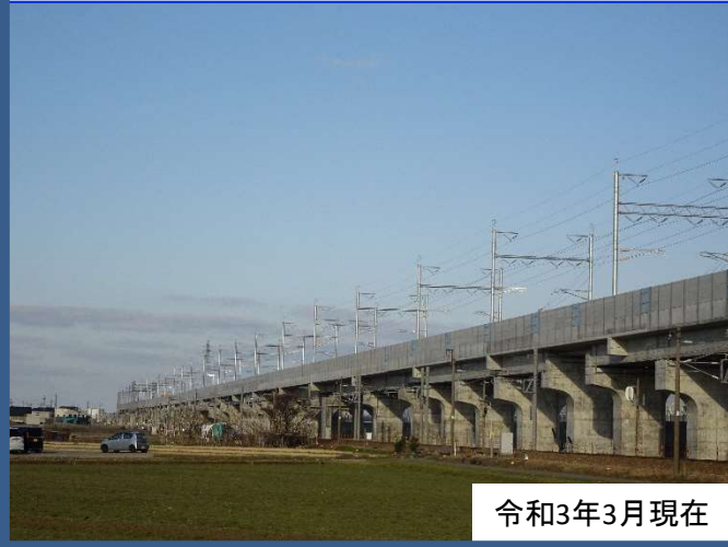
白山宮保高架橋【白山市】
