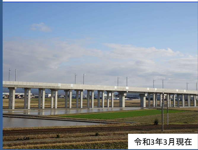
白山北島高架橋【白山市】
