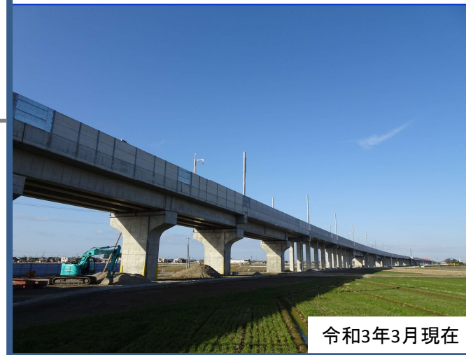
川北橋高架橋【白山市～川北町】
