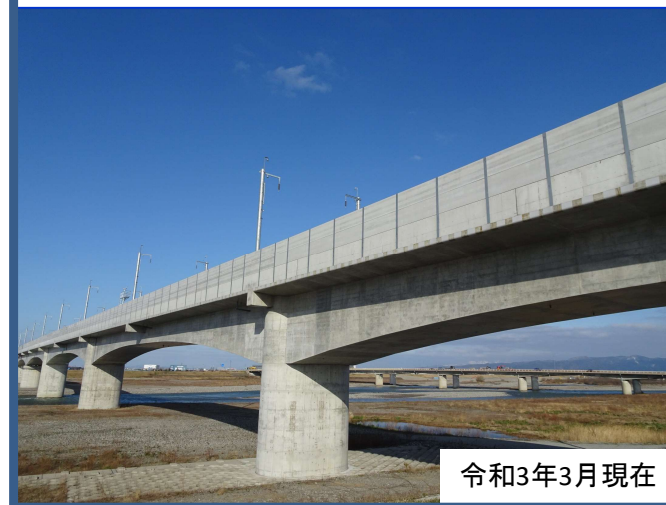
手取川橋りょう【川北町～能美市】
