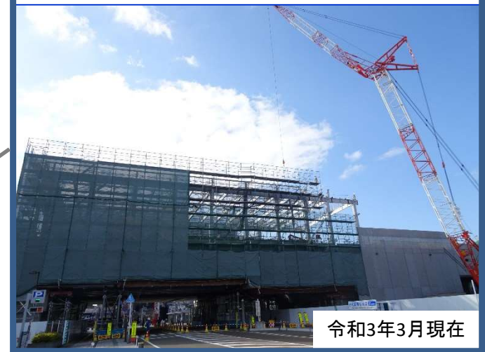
小松駅高架橋【小松市】
