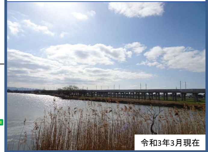
小松木場潟高架橋(南)【小松市】
