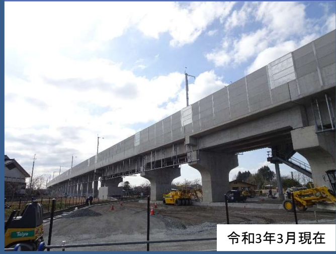
小松粟津高架橋【小松市】
