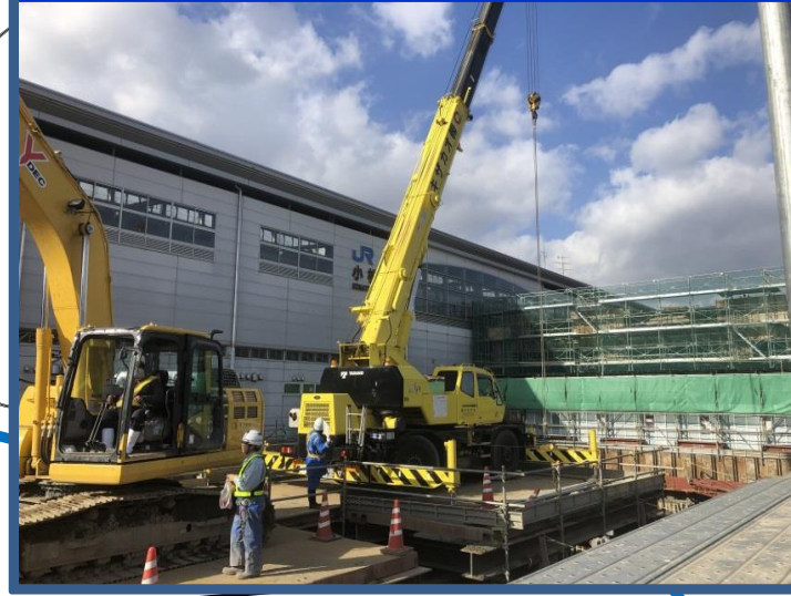
小松駅高架橋【小松市】
