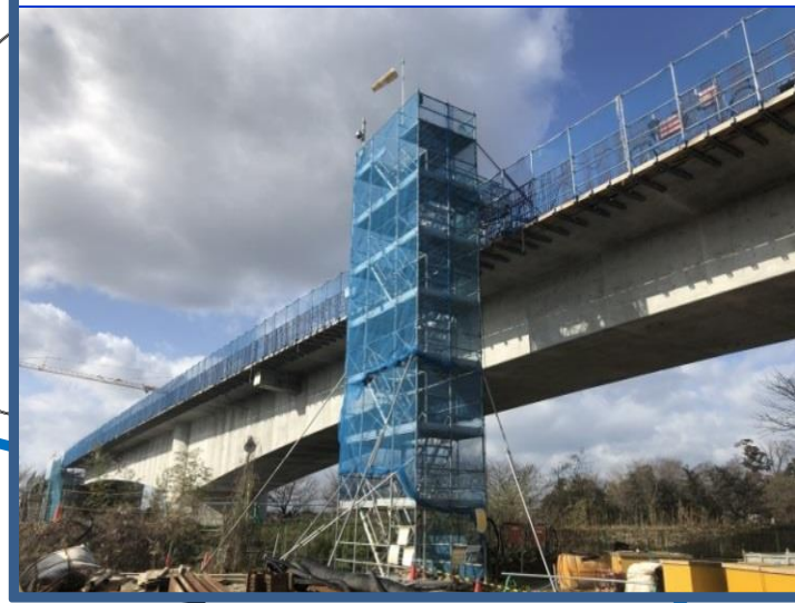
動橋川橋りょう【加賀市】
