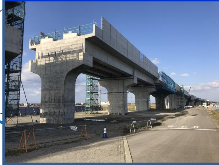
川北橋高架橋【白山市～川北町】
