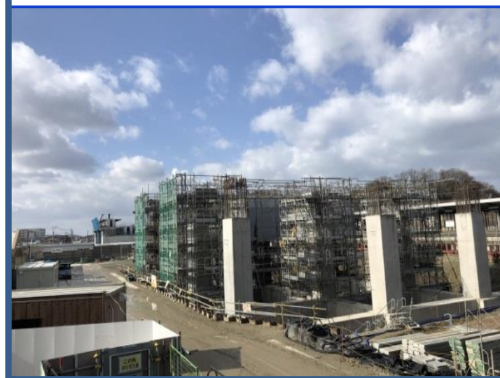
加賀温泉駅高架橋【加賀市】
