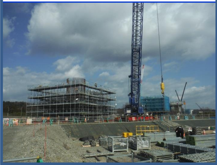
大聖寺川橋りょう【加賀市】
