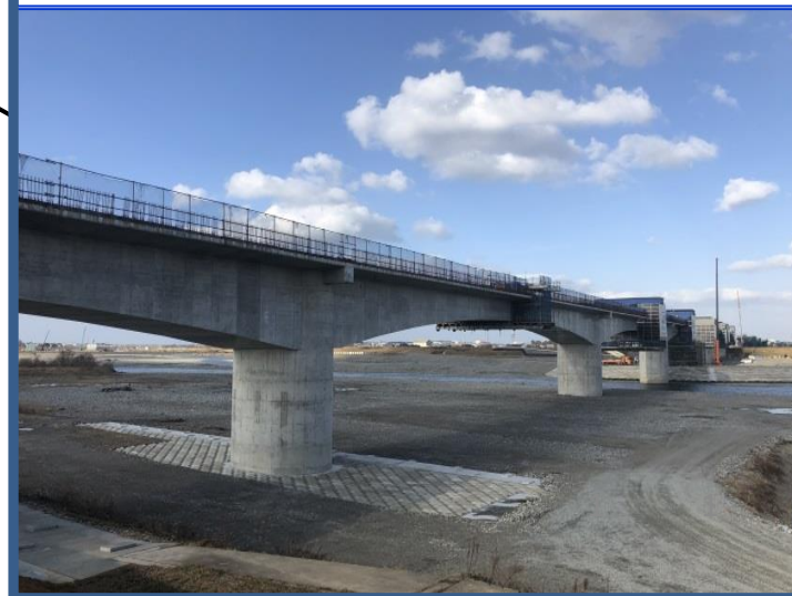
手取川橋りょう【川北町～能美市】
