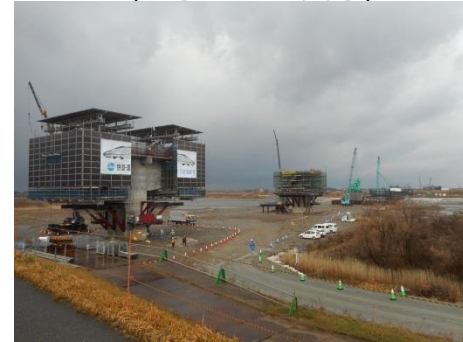
手取川橋りょう (川北町~能美市)
