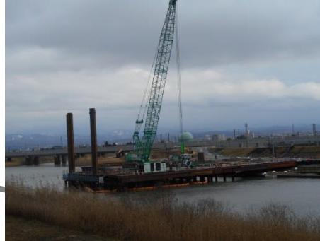
梯川橋りょう(小松市)
