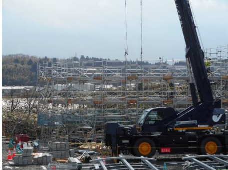
大聖寺川橋りょう(加賀市)
