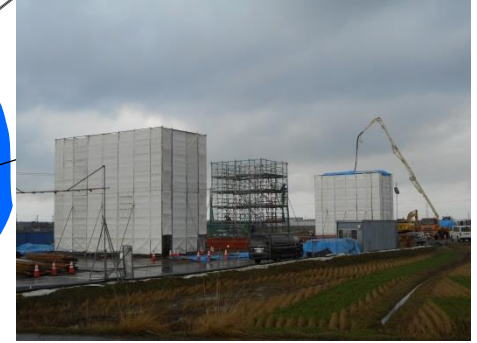
川北橋高架橋 (白山市~川北町)
