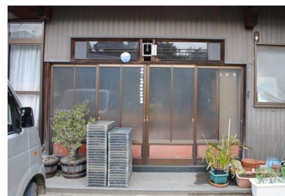
ツバメだけが玄関内に入れるように扉の上に隙間をあけている
