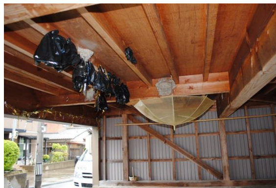
巣の周りにビニールを吊り下げてヘビ除け、傘を逆さにしてフン除けにしている
