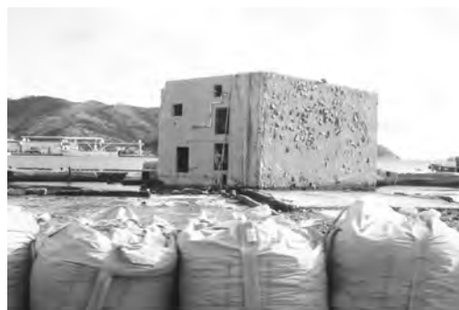
宮城県女川町 津波で倒れたビル H23年度
