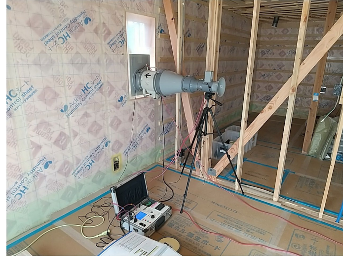
中間時・完成時の2回測定
