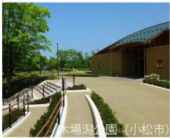
瓦リサイクル景観舗装材 (K-グランド)の施工例
