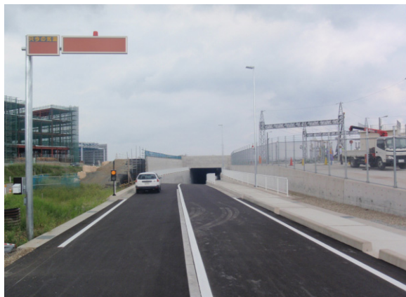
東側から西方(海側)を望む
