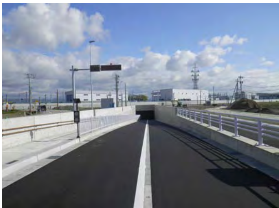
北側から南方(海側)を望む
