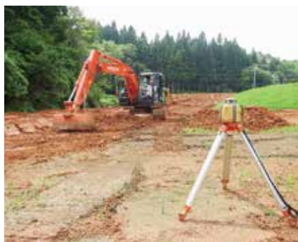
工事写真(区画整理)
