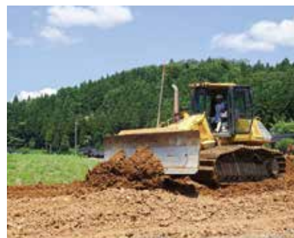
施工中写真(ブル)
