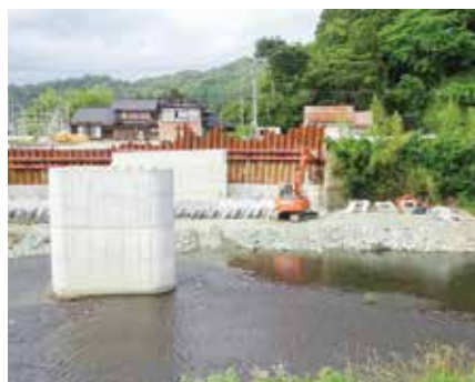
工事写真(橋脚工)
