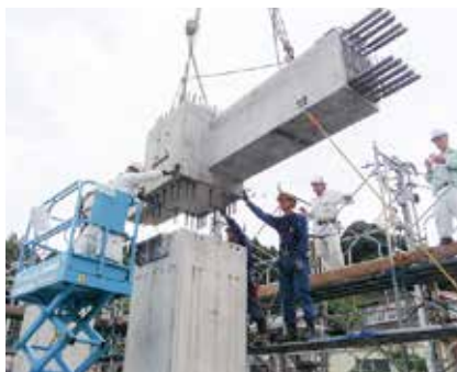
建築構造物のプレキャスト工法現場
