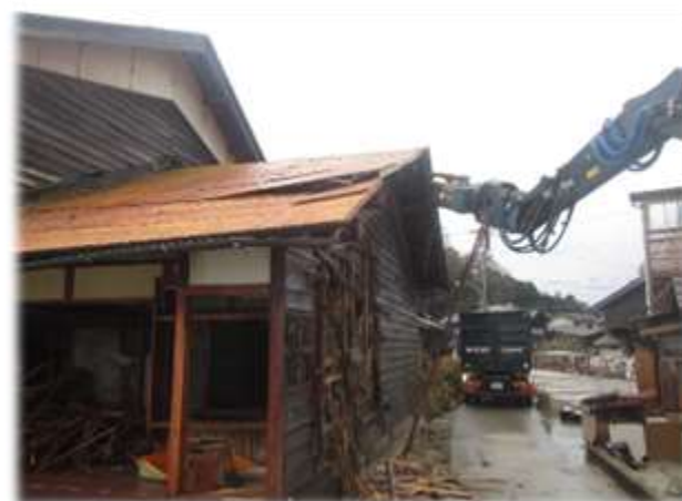
公費解体の様子
